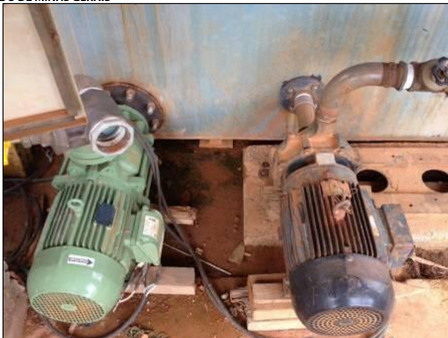
Detalhe Bomba distribuição ETA
